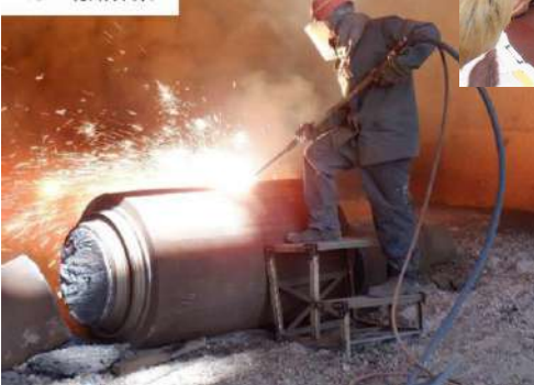
ガス切断作業
